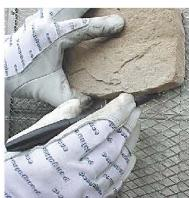
色調のバランスを考えストーンを割りつけます。ドットピンの取り付け位置に墨出しします。ゴミ、ほこり等をきれいに取り除いたストーン裏面に接着剤をつけて(1枚につき2~3点)固定して下さい。
