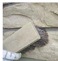
モルタルパック等を使用して、目地部にモルタル目地材を詰めていきます。目地モルタルの硬化を確認した後、仕上ります。竹べら等で余分な目地をかき落としながら押し込み、ブラシ等でストーンに付着した目地材を除去して下さい。
