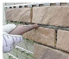
フラット面のタイルの場合、目地材をゴム鎌を使って塗り付け、スポンジで余分な目地材を取り除き目地押さえを行います。特殊表面タイルはモルタルパック等を使用して1本目地詰めを行います。
